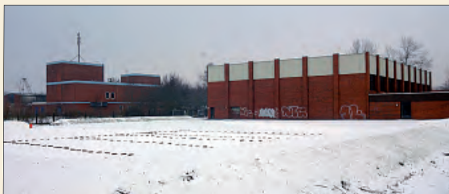
Hinter der großen Turnhalle entsteht die Freizeitanlage – allerdings ohne Laufbahn. Die KGS-Sportlehrer wünschen sich einen Kunststoff-Belag, der rund 33 000 Euro kosten würde. Eine normale Aschenbahn würde die Hälfte kosten. FOTO: FOORTMANN
