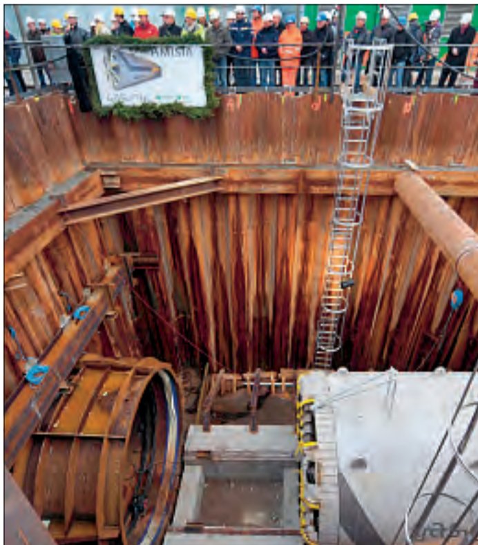
Auf den Namen „Amista“ wurde die Bohrmaschine getauft, mit der ein Tunnel unter der Ems gebohrt werden soll. FOTO: DPA
