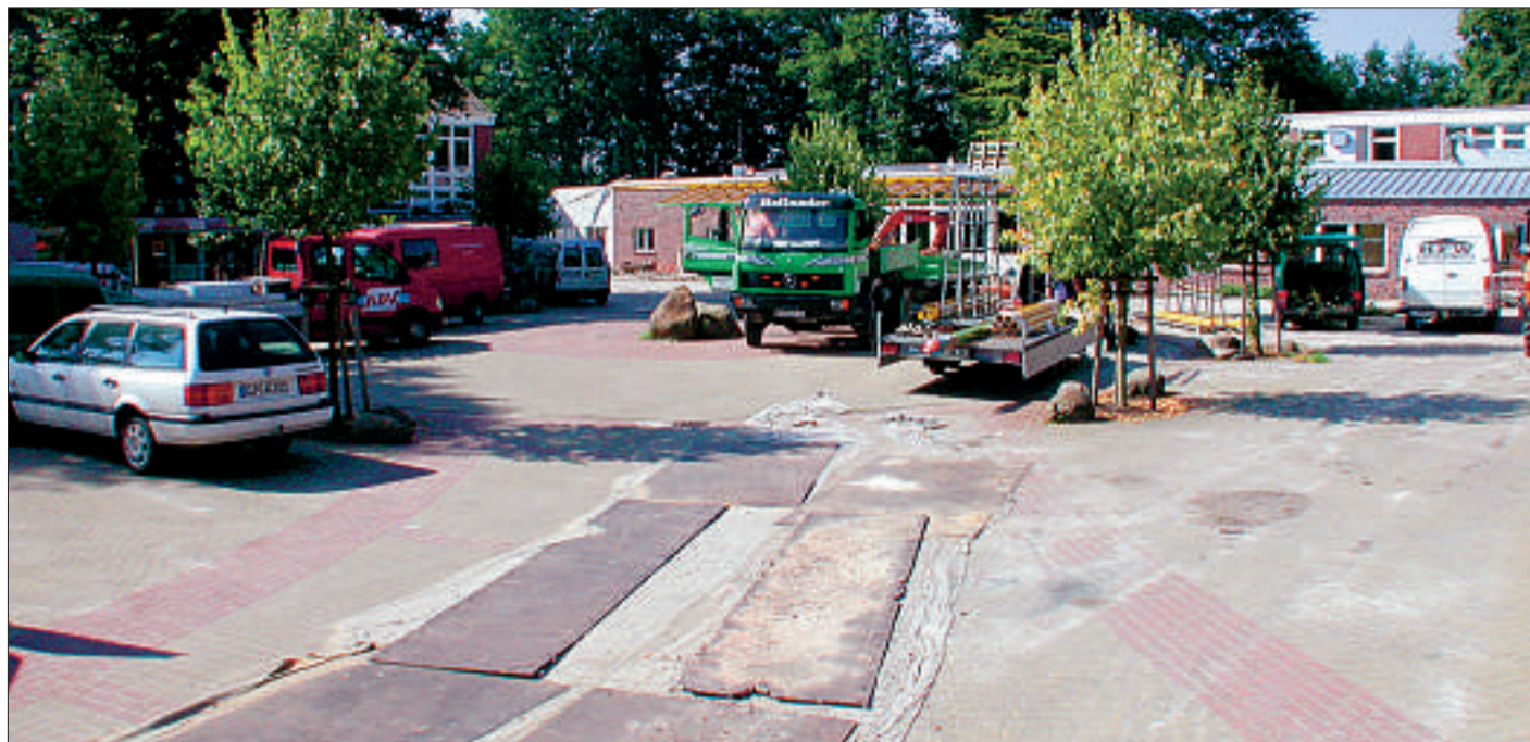
Großbaustelle KGS – bis nächste Woche soll der erste Bauabschnitt so weit abgeschlossen sein, dass die Schule beginnen kann. FOTO: FRANSEN
