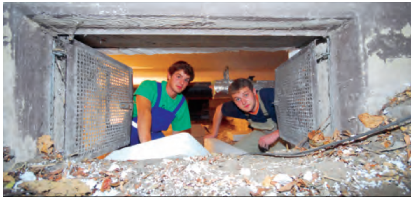
Im Wildbahngebäude laufen die Arbeiten zur Verbesserung der Wärmedämmung.
