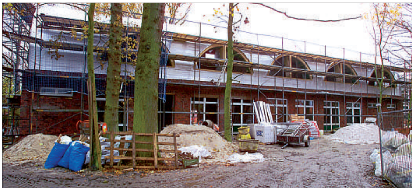
Unverzichtbar für eine Ganztagschule ist der Freizeitbereich, der in diesem Gebäude im Untergeschoss entsteht. Im Obergeschoss wird künftig der Fachbereich Neue Technologien untergebracht sein. Das Dach besteht aus langlebigen beschichteten Aluminiumblech. Durch die Bauform kann das Obergeschoss voll genutzt werden. Sie ist laut Planer Peter Voss nicht teurer als eine konventionelle Ausführung.
